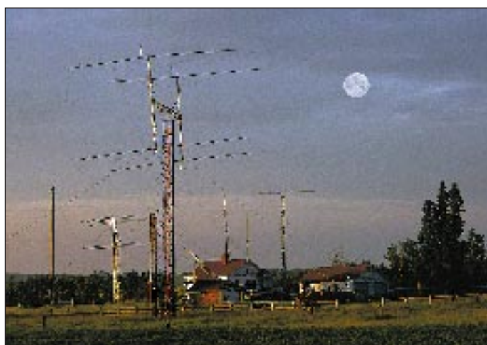
Jacks Antennenfarm in der kanadischen Provinz Alberta: Eine solche Antennenanlage wäre im dichtbesiedelten Deutschland undenkbar.
